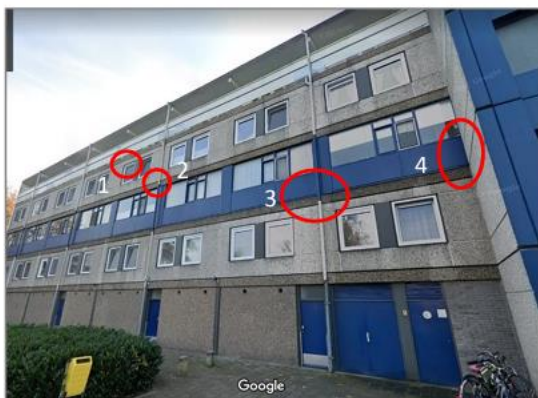
Afbeelding 2.1 | Vier zomerverblijfplaatsen van gewone dwergvleermuizen aan de linker voorzijde van het complex.
