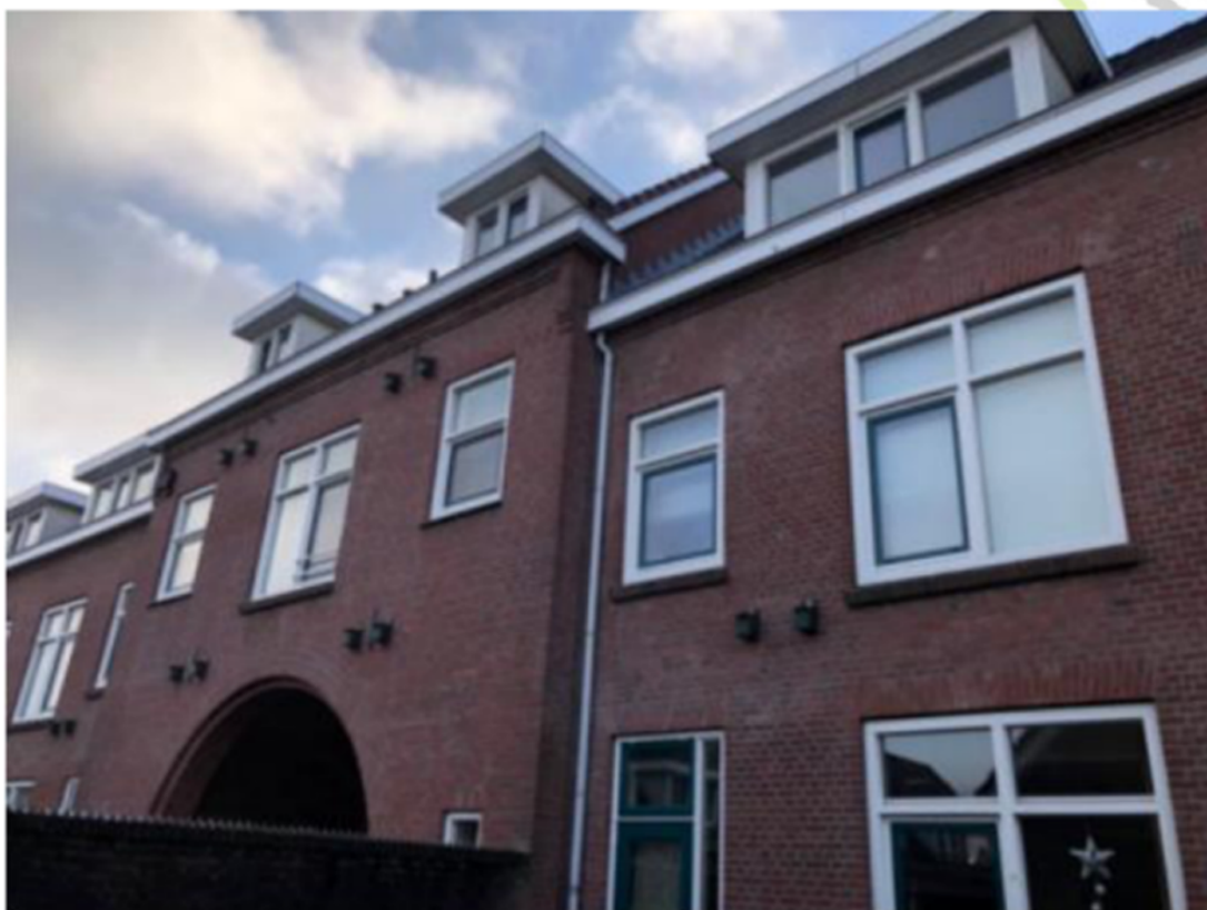
Figuur 6. Systeem-nestkast huismus Eco aan verschillende woningen aan de achterzijde van de Dubbeldamseweg Zuid. Foto: [redacted] | Ecoresult B.V.
