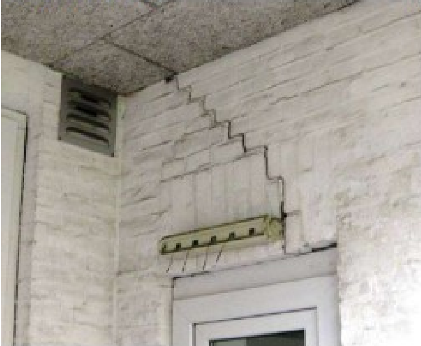
Scheurvorming ag pand 19
