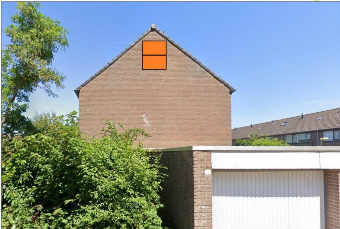
Figuur 8 Kraamkast vleermuizen inbouw
