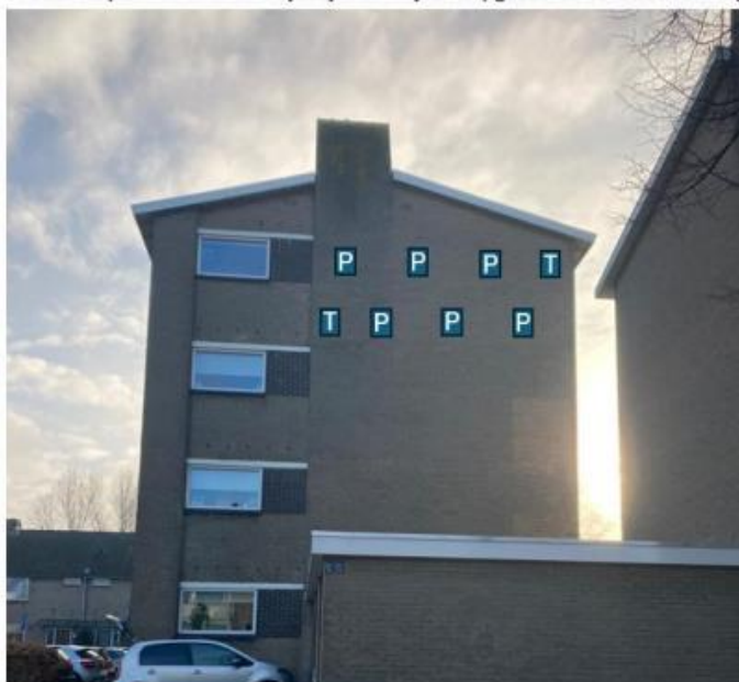
Fase 3: 6 permanente en 2 tijdelijke verblijven kopgevel ten behoeve van migratie vleermuizen langsgevel straatzijde
