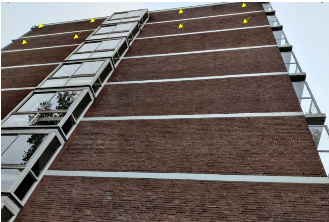
Figuur 5 Locatie inbouwvoorzieningen kopgevel (Laneco, 2025)
