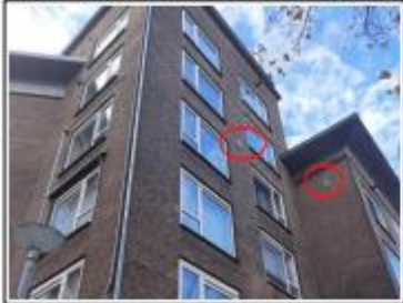
Foto 3 2x MARK; noord- en oostgevel Pleinweg 202-204
