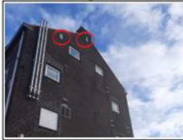
Foto 2 2x MARK; westgevel Brielselaan 167
