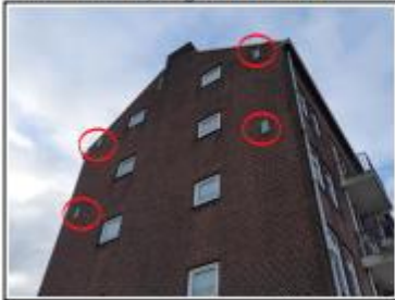
Foto 1 4x MARK; oostgevel Brielselaan 161
