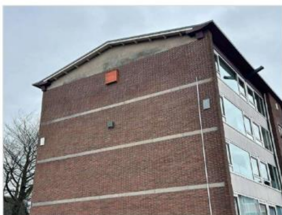
Figuur 6.2 Noordgevel van de Van Hoornstraat 44 met vier verschillende tijdelijke vleermuiskasten.
