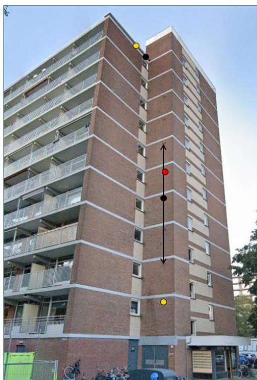
Figuur 4 Weergave van invliegopeningen in het flatgebouw Dulf. De openingen betreffen ventilatieroosters in het trappenhuis en daklijsten aan de kopgevel van de woningen.
