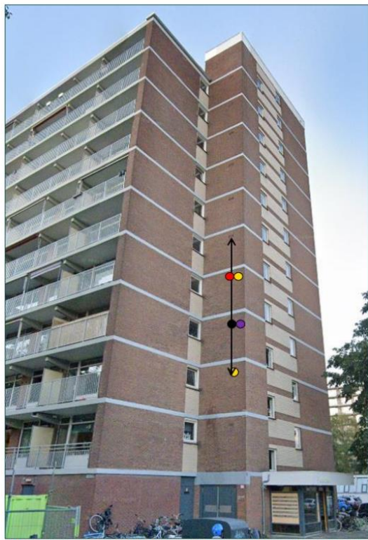
Figuur 3 Weergave van invliegopeningen in het flatgebouw Bulzerd. Alle openingen betreffen ventilatieroosters.
