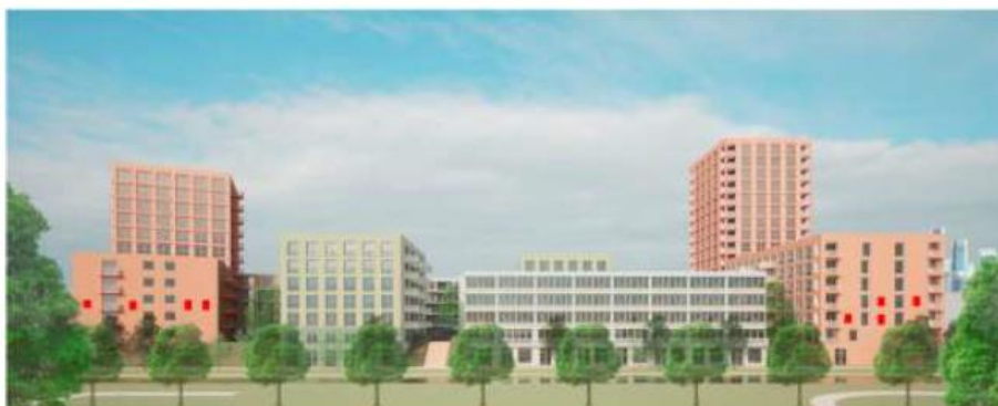
Figuur 3 Inbouwvoorzieningen aan de oostzijde van het plangebied langs de watergang.
