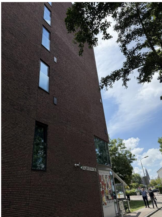
Figuur 4 Locatie tijdelijke voorzieningen, noordgevel van de Koepoortplaats 2.
