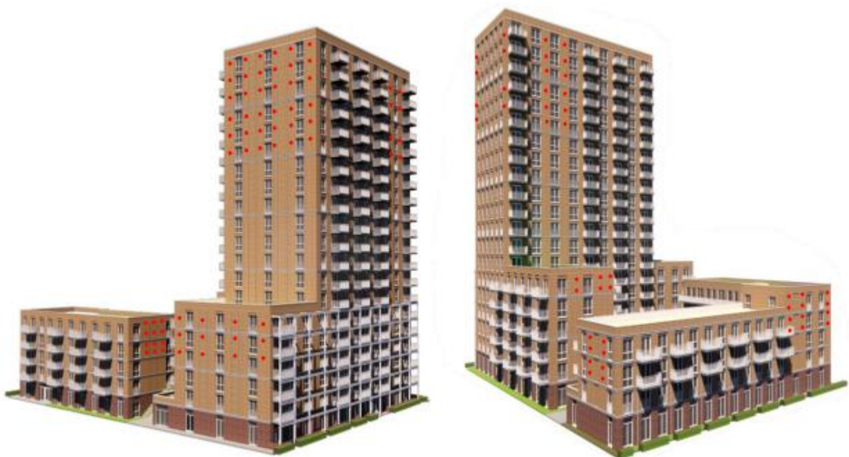
Figuur 4 Links: Zuidelijk georiënteerde gevel van Zichten 2. Rechts: Noordelijk georiënteerde gevels van Zichten 2. rode stippen geven geschikte locaties voor open stootvoegen.
