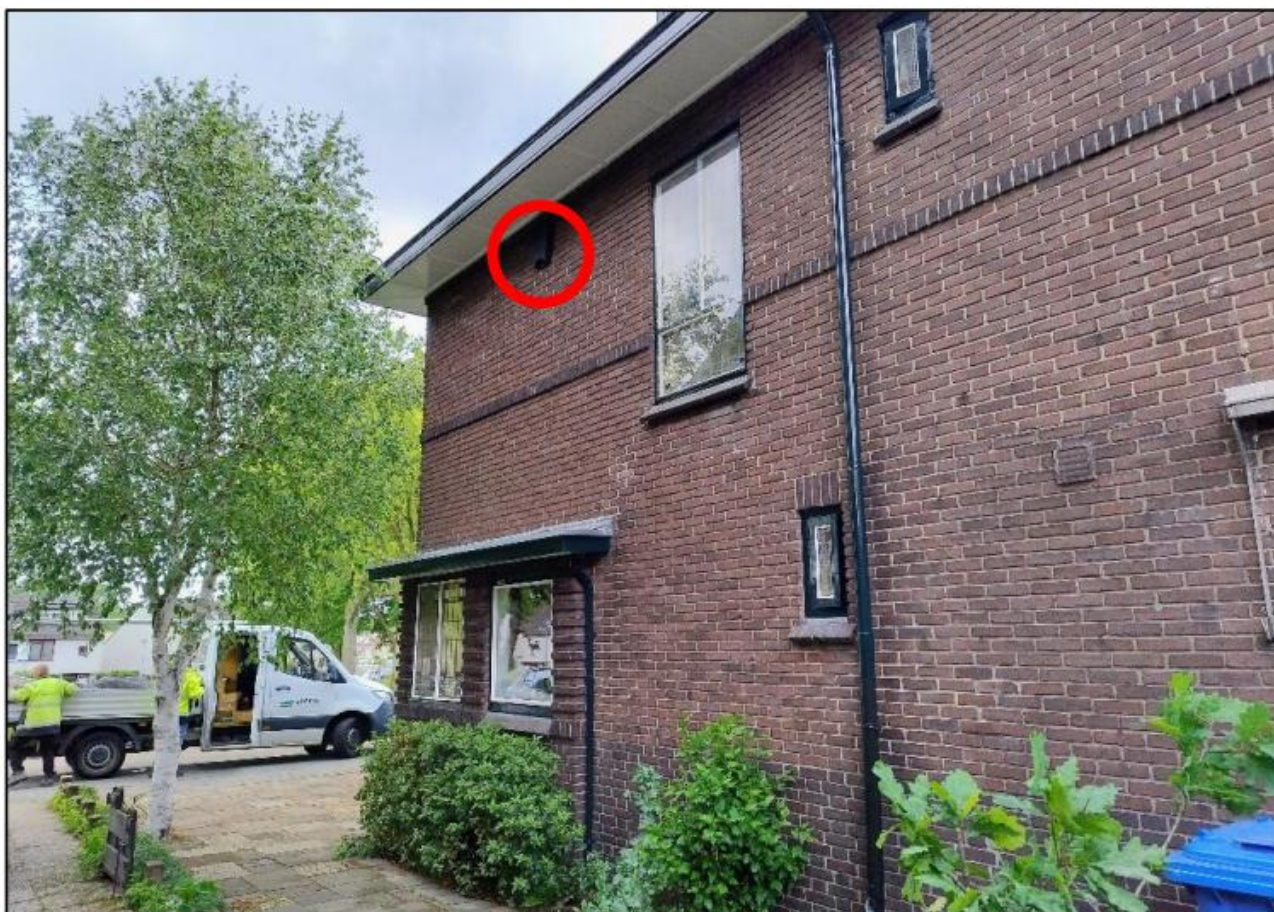
Figuur 7: Vleermuiskast aan de zuidgevel van Schiebroeksesingel 30, rood omcirkeld.
