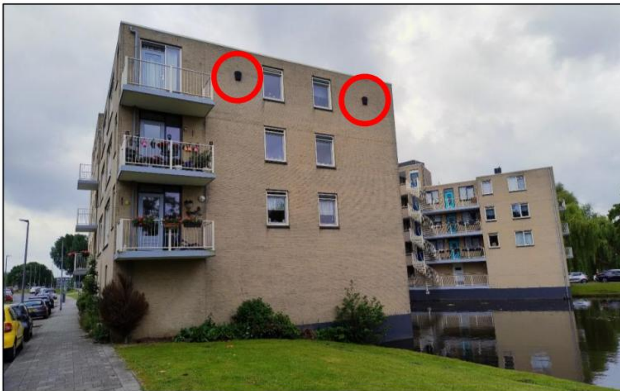
Figuur 13: Vleermuiskasten aan de noordoostgevel van Ringdijk 181, rood omcirkeld.
