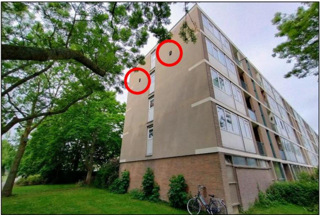
Figuur 11: Vleermuiskasten aan de zuidgevel van Van Bijkershoekweg 15-85, rood omcirkeld.
