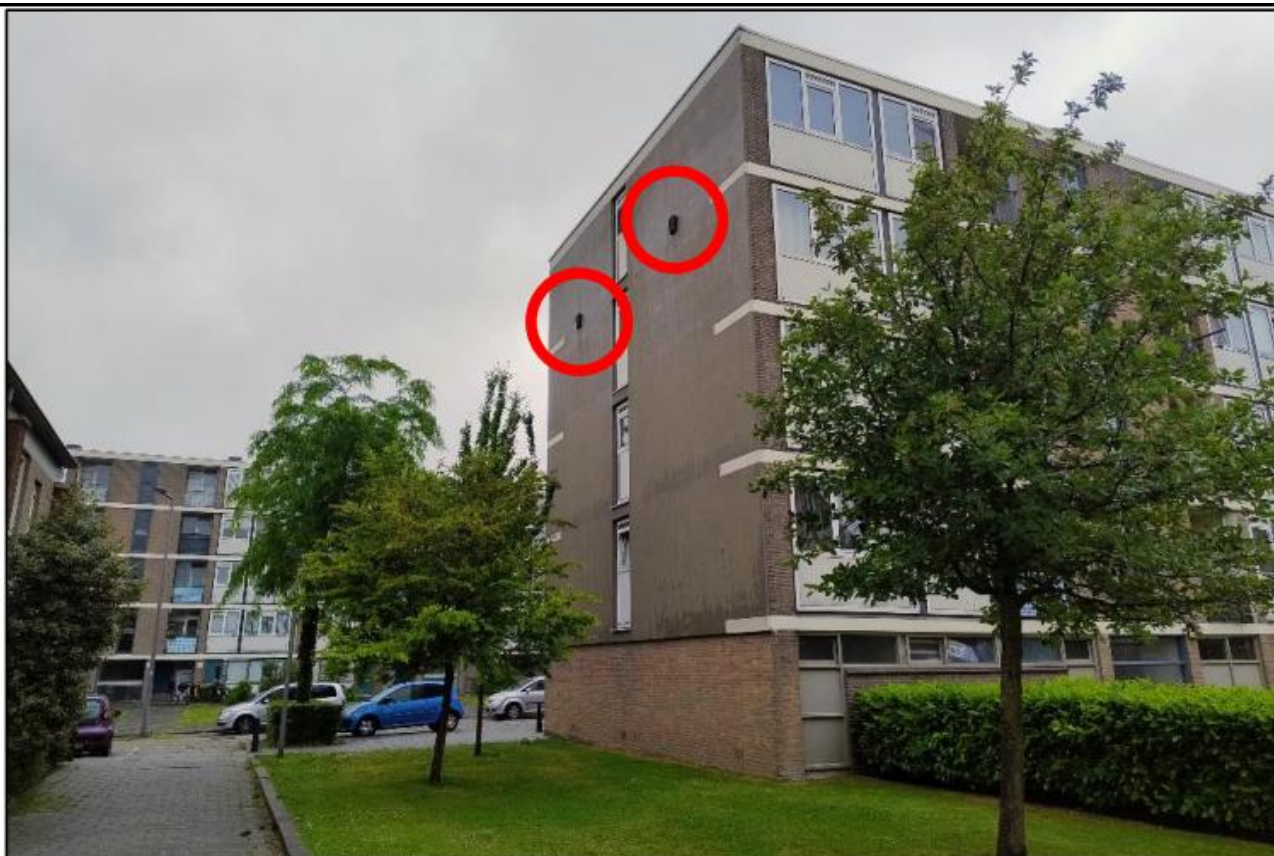
Figuur 8: Vleermuiskasten aan de zuidgevel van Van Bijkershoekweg 8-138, rood omcirkeld.
