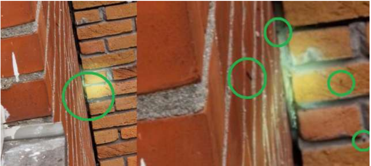
Figuur 4 Detailfoto's van de dilatatie met groen omcirkeld de uitwerpselen.
