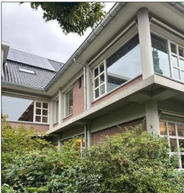
Figuur 1: De tijdelijke vleermuiskast op de gevel met een noordwestelijke oriëntatie.
