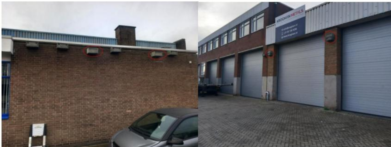
Figuur 1 Rood omcirkeld zijn de kasten ophangen op 18 december 2025. De andere kasten hangen al sinds 18 juni 2025. Bron aanvullende informatie van 22 december 2025
