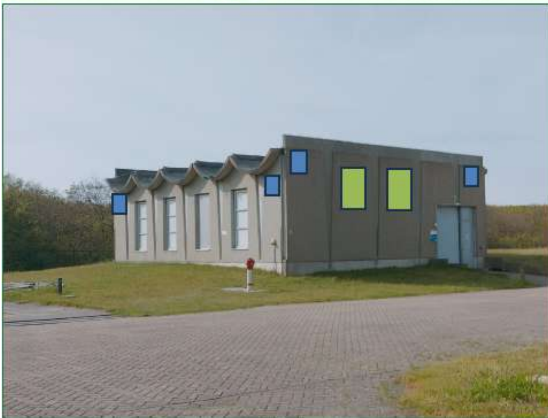
Locaties tijdelijke en permanente voorzieningen vm fase 1. Rode pijlen = kraamkasten. Blauwe vakken= elke zijde 2 tijdelijke vm kasten VMT1 of soortgelijks, voorbeelden van locatie plaatsing in de afbeelding
