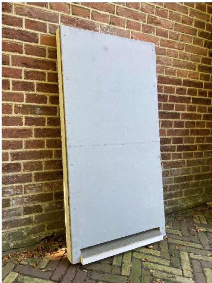
Figuur 13: Voorbeeld van een inbouwkast welke kan worden toegepast bij de permanente compensatie voor de gewone dwergvleermuis. Foto: Archief Staring Advies.
