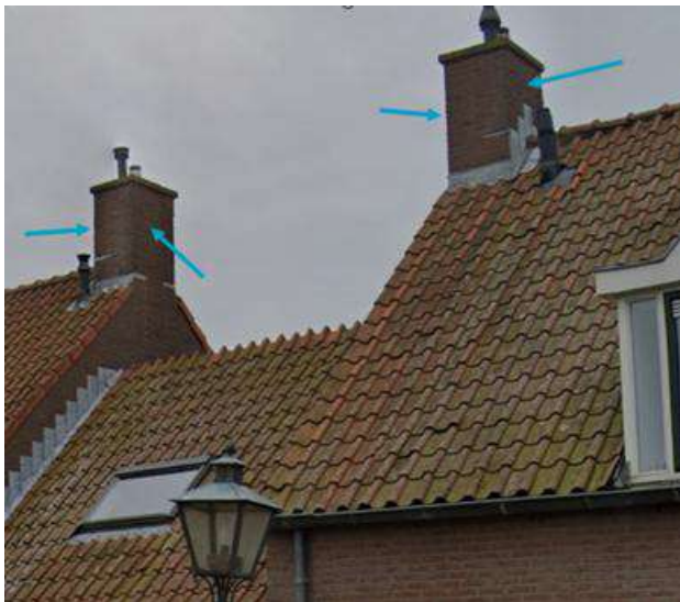
Afbeelding 1: tijdelijke kasten op de schoorstenen van de Zoutziederstraat 5 en 6, gericht op het westen en oosten
